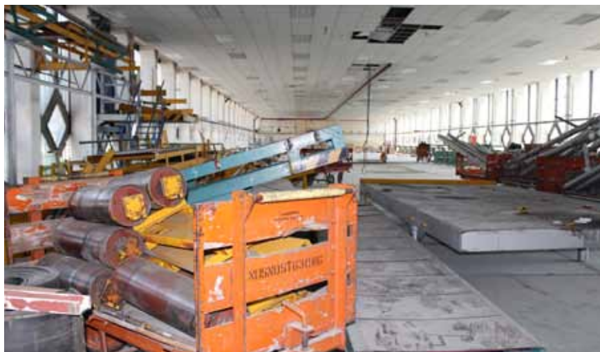
Po demontáži pôvodných zariadení čakajú halu nevyhnutné stavebné úpravy.
